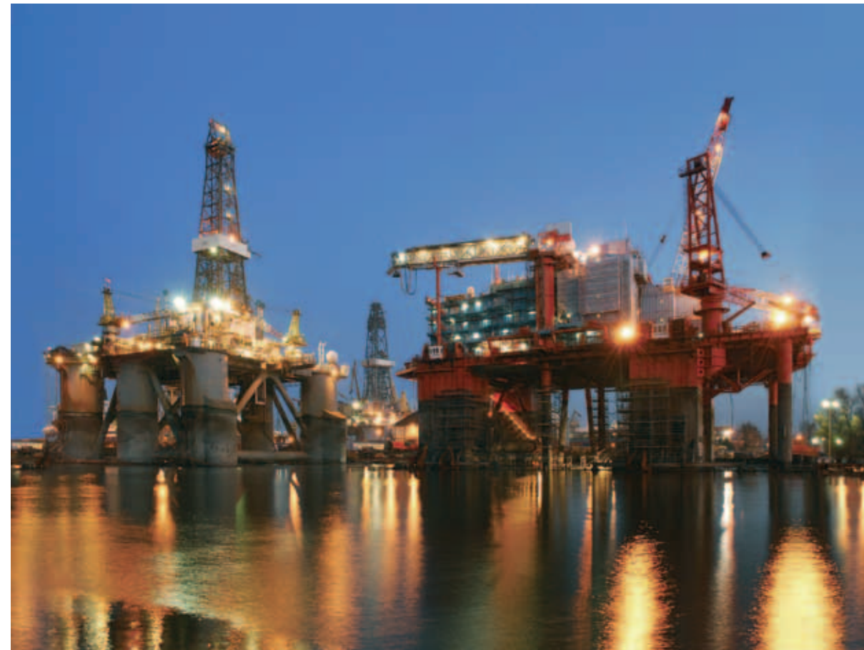
Gigantyczne platformy wiertnicze w Remontowej S.A. to stały element krajobrazu Gdańska.
