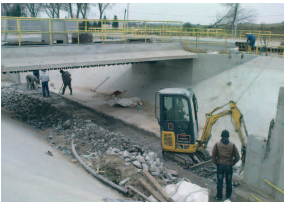
Przebudowa istniejącego rowu cyrkulacyjnego
