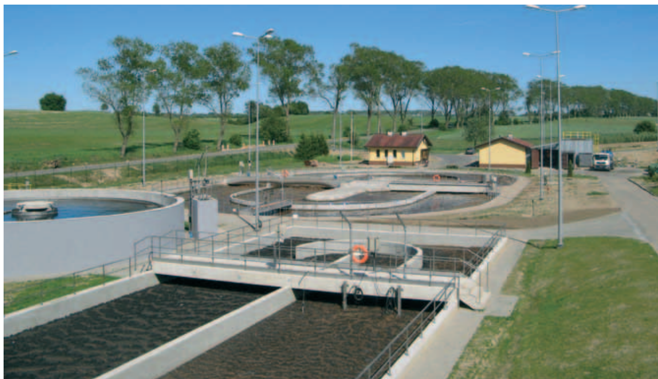
Oczyszczalnia ścieków w Gniewinie po modernizacji.
