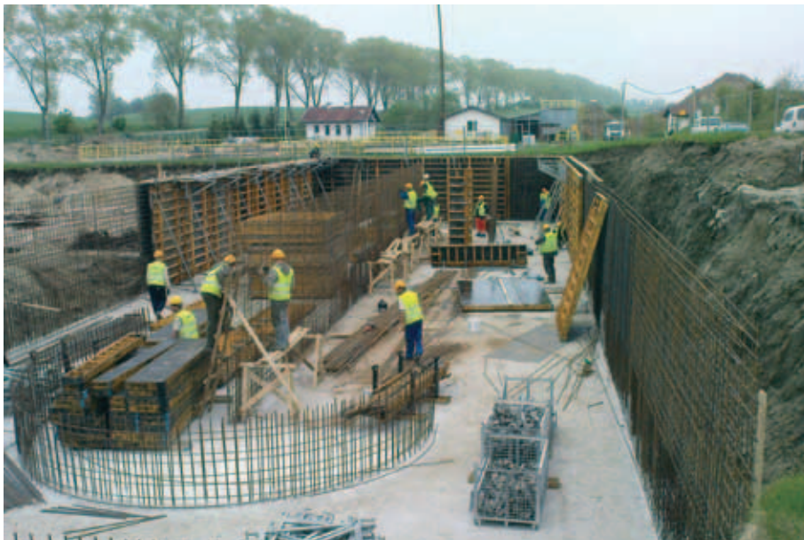
Zbrojenie i szalowanie komory denitryfikacji
