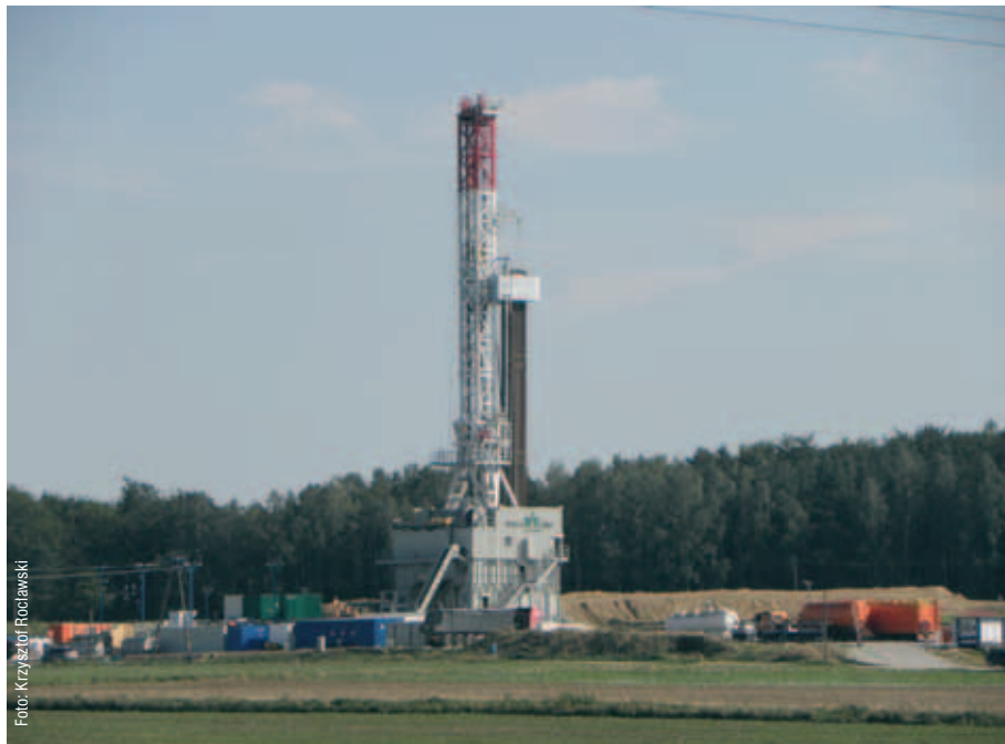
Wiertnia gazu w Lubocinie
