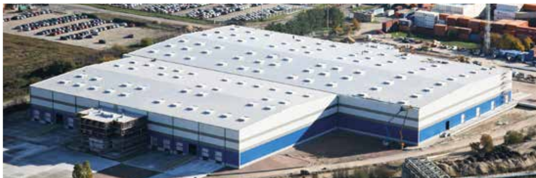
Nowo budowany magazyn wysokiego składowania na terenie Centrum Logistycznego w Porcie zachodnim. Fot. T.Urbaniak/ZMPG-a S.A.
