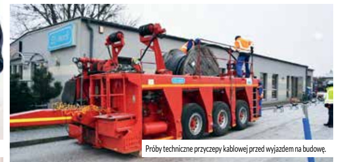
Budowa linii kablowej 110 kV na Farmie Wiatrowej.
